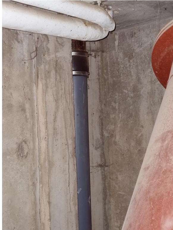
Utbytt avloppsrörs pga. läckage
